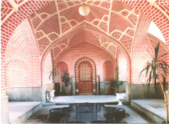
تصویر شماره ۱۰: نقوش آجری خفته و راسته و... در عناصر رسمی بندی، حوض‌خانه منزل قدکی تمبریز (دوره قاجاریه)؛ مأخذ: تصویر از آرشیو دانشگاه هنر اسلامی تبریز
