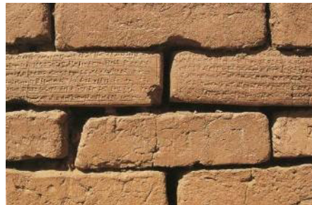
تصویر شماره ۲: آجرنوشته‌ها از احکام عیلامی جزئی از بنا رج‌های آجرکاری بنای چغازنبیل؛ مأخذ: نگارندگان
