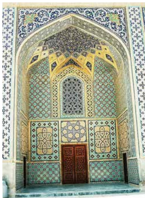
تصویر شماره ۶: رسمی بندی نیم کار ایوان شمالی، بقعه خواجه ربیع، مشهد مقدس (دوره صفویه)؛ بازسازی، مرمتگری و تصویر از نگارنده
