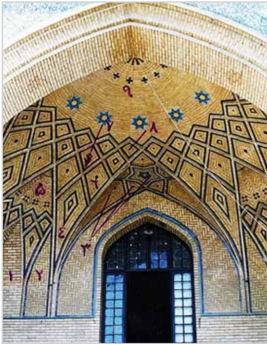
تصویر شماره ۲: نمود عناصرهای رسمی بندی نیم کار؛ مأخذ: نگارنده
