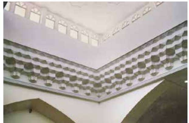
تصویر شماره ۳۹: قطاربندی پیش‌ساخته زیر سقف، مصالی بزرگ تهران؛ معاصر امروز؛ مأخذ: نگارنده
