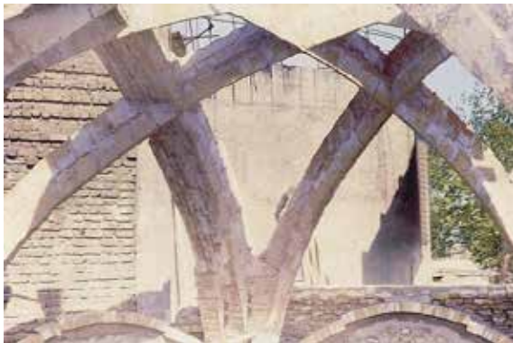
تصویر شماره ۱۲: مجموعه اسکلت «تویزه» کاربندی رسمی آجری، وضوخانه زنانه مسجد دانشگاه صنعتی شریف؛ معاصر نزدیک؛ مأخذ: نگارنده
