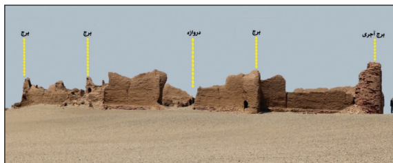
شکل ۱۴- نمای ضلع جنوبی رباط (کاروان‌سرا) بیابان گرگ
