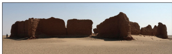
شکل ۱۶- دورنمای ضلع شرقی رباط بیابان گرگ
