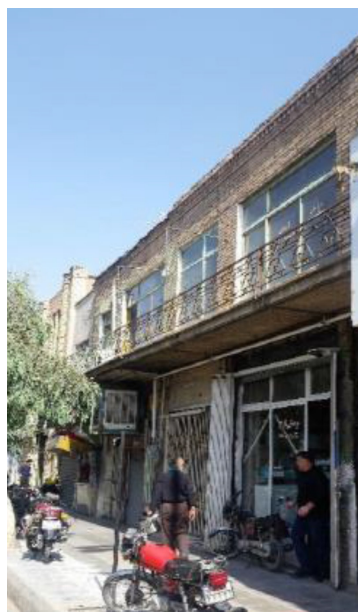
تصویر شماره ۳۵: سایه بان روی پیاده رو؛ نمونه بی ستون؛ تجاری پشت بازار نو
