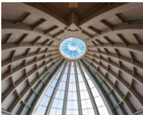
شکل 22. استفاده از مصالح سازه‌ای نوین و سلول‌های شفاف در پوسته (ماخذ: URL15)
