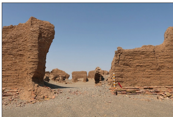
شکل ۱۷- پایه‌های آجری بنا، بقایای ورودی بنا با نمایی از بقایای فضاهای خشتی داخل بنا
