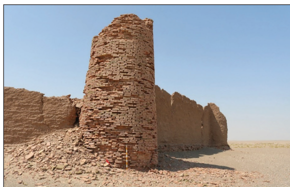
شکل ۱۸- برج آجری گوشه شرقی ضلع جنوبی رباط (کاروان‌سرا)
