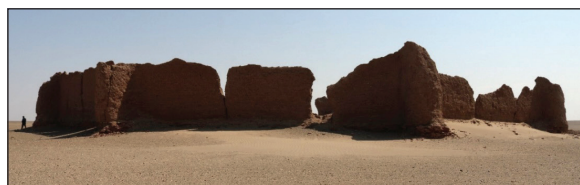
شکل ۱۶- دورنمای ضلع شرقی رباط بیابان گرگ
